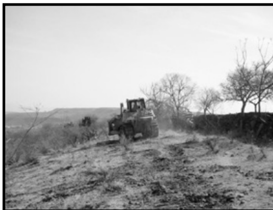
Imagen 76. Desarrollo de trabajos dentro de las áreas delimitadas
