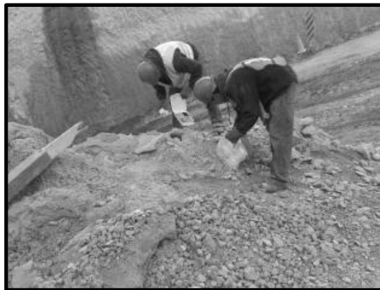
Imagen 84. Recolección de residuos en la obra por parte del personal de la brigada ambiental.
