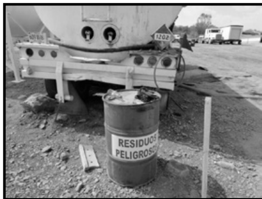
Imagen 81. Tambos para Residuos Peligrosos colocados en los diversos frentes de trabajo.
