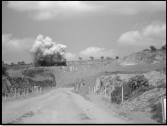
Ilustración 26. Evidencia de voladura en el Banco la Palma.
