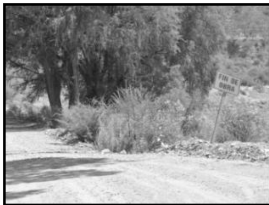
Ilustración 74. Límites de la zona de construcción de la cortina.
