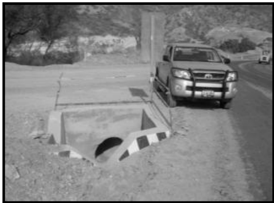
Imagen 74. Instalación temporal de tubería para canalizar los escurrimientos.
