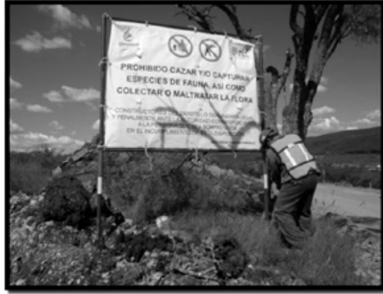
Imagen 19. Instalación de lonas informativas/prohibitivas en diferentes zonas de la obra para conocimiento del personal.
