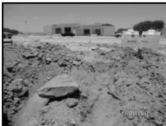
Ilustración 34. Construcción del bloque de casas habitación consideradas en la segunda etapa.
