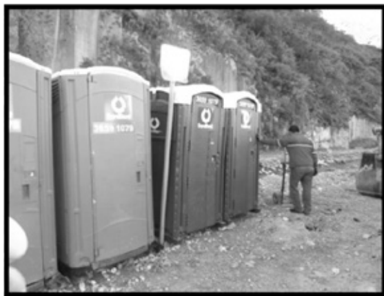
Imagen 20. Sanitarios portátiles instalados en obra, se toma en cuenta la cantidad de personal en el área.
