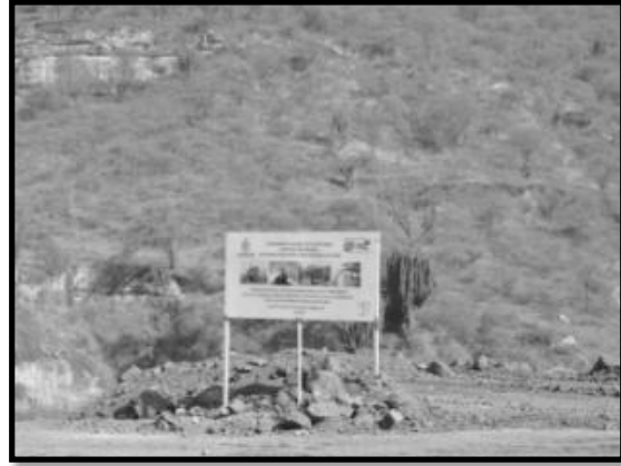
Ilustración 64. Lonas informativas y prohibitivas de protección ambiental dispuestas en la zona de obra.
