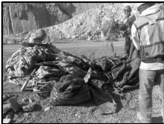
Imagen 83. Brigada ambiental recolectando residuos de manejo especial en la zona de obra.
