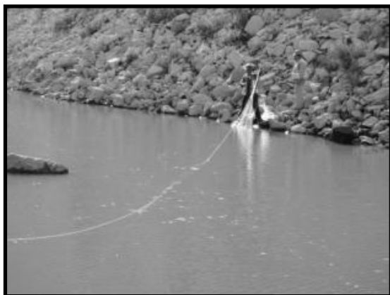
Ilustración 103. Colocación de red para evitar el paso de fauna durante desazolve de aguas abajo
