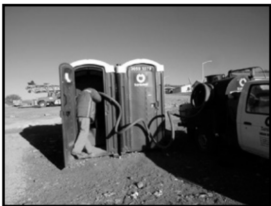
Imagen 72. Limpieza de sanitarios portátiles instalados en obra.
