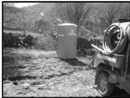
Imagen 24. Se les realiza limpieza cada tercer día a todos los sanitarios colocados en la obra y el número de las mismas corresponde al número de personas en obra.
