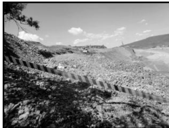
Imagen 57. Acordonamiento de los límites de la zona de construcción para evitar el paso a las áreas de riesgo.
