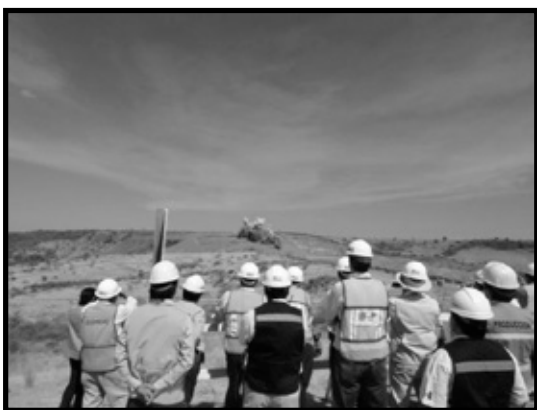
Imagen 27. Voladuras en Banco de Materiales La Palma.
