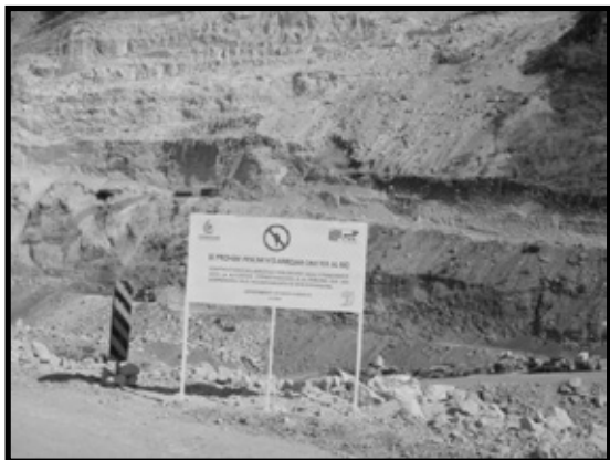
Imagen 62. Carteles informativos/prohibitivos colocados en sitios estratégicos para que los mismos sean visibles por todo el personal obrero.
