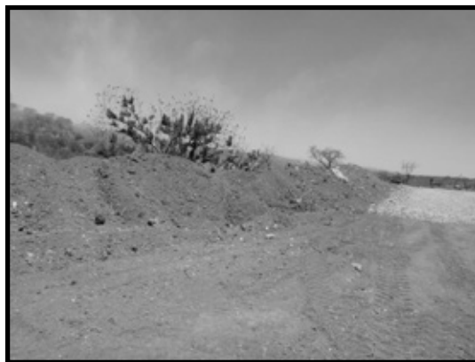
Imagen 77. Capa superficial del suelo colocado en pilas para su posterior uso.
