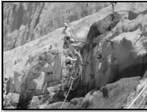
Imagen 50. Amacice de taludes en zona de obra.
