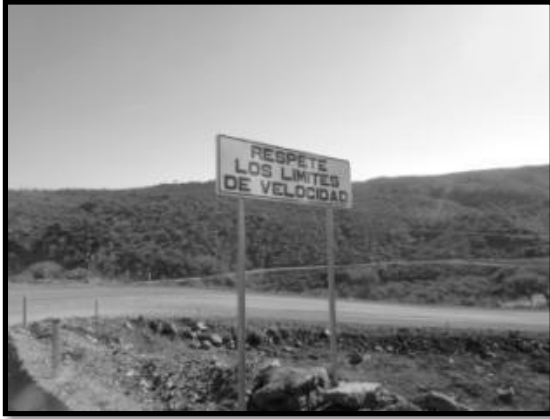
Ilustración 100. Colocación de señalamientos viales en zona de obra.
