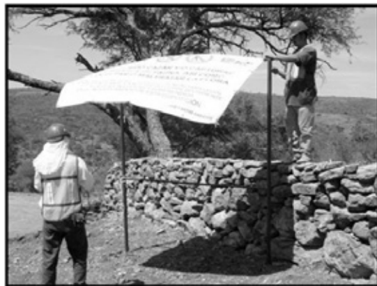
Imagen 22. Mantenimiento y revisión de lonas colocadas en la obra.
