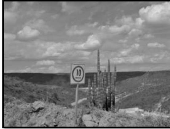
Ilustración 101. Colocación de señalamientos viales en zona de obra.
