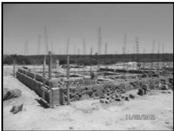
Ilustración 35. Actual vista de la etapa de construcción de las viviendas.
