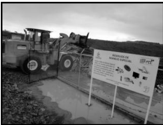
Imagen 89. Maquinaria maniobrando el depósito de los materiales de desecho en Almacén Temporal de RME.
