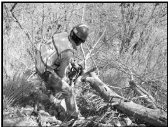
Imagen 79. Eliminación de residuos forestales mediante el uso de motosierras.
