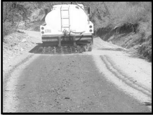
Imagen 5. Como medida de mitigación de emisión de partículas al aire se riegan los caminos utilizados por la maquinaria así como por los vehículos pertenecientes a la empresa constructora.
