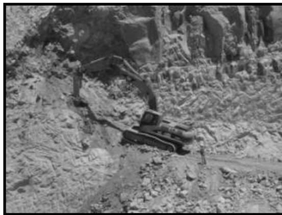
Ilustración 68. Estabilización de taludes por seguridad del personal obrero y maquinaria.
