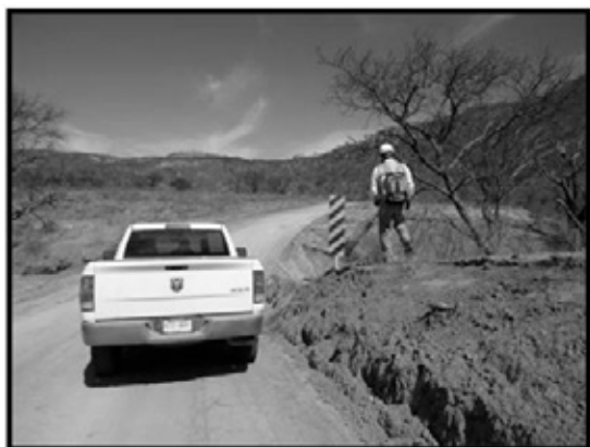
Imagen 16. Instalación de señalamientos viales a lo largo de los accesos a la obra.
