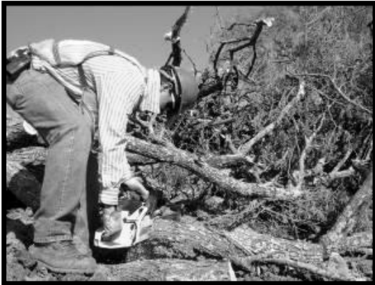
Imagen 24a. Motosierras utilizadas para eliminación de materia orgánica en los frentes de trabajo.
