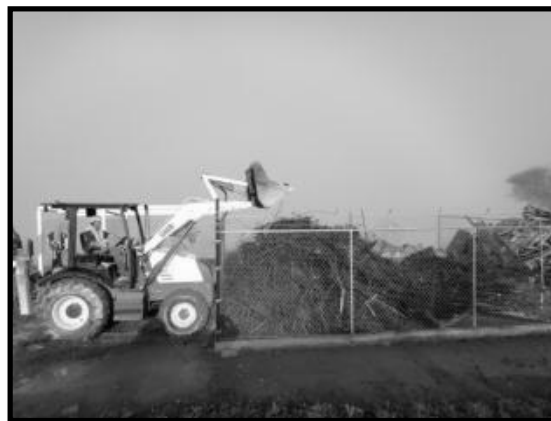
Imagen 90. Vista parcial del almacén temporal de RME.
