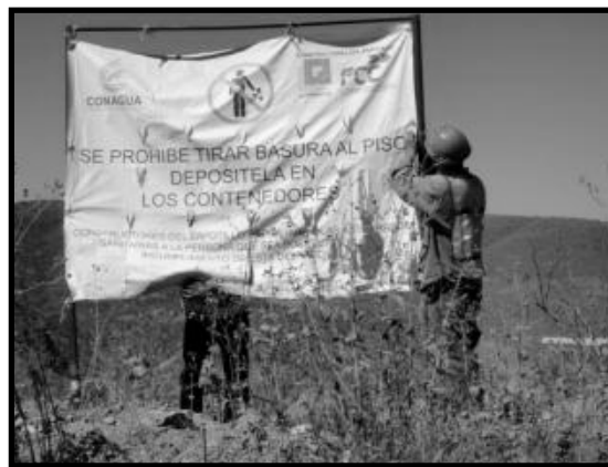
Imagen 67. Mantenimiento y reemplazo de carteles informativos/prohibitivos colocados en obra para conocimiento del personal.
