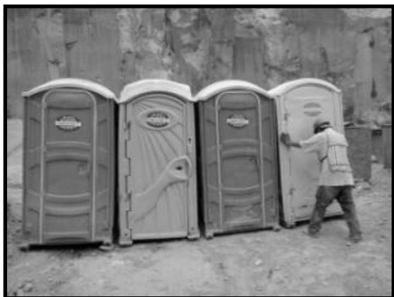
Ilustración 82. Sanitarios portátiles distribuidos en obra.
