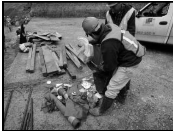
Imagen 21. Limpieza de los frentes de trabajo.
