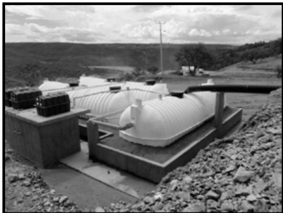
Imagen 23. Vista panorámica de la PTAR.
