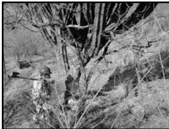
Imagen 80. Desmonte y despalde en áreas de impacto.
