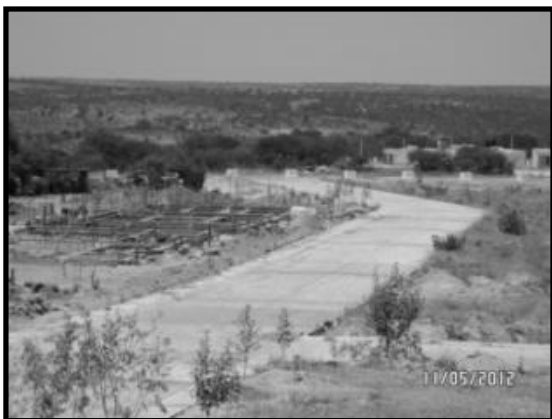
Ilustración 31. Vista del sitio donde se construye la segunda etapa.
