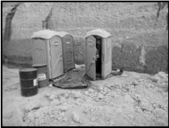
Imagen 68. Sanitarios portátiles distribuidos estratégicamente en zona de obra.
