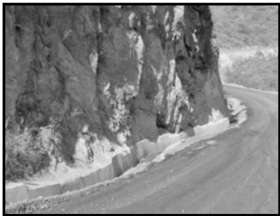
Ilustración 88. Obras para manejo de escurrimientos pluviales.
