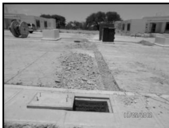
Ilustración 30. Instalación de infraestructura subterránea.
