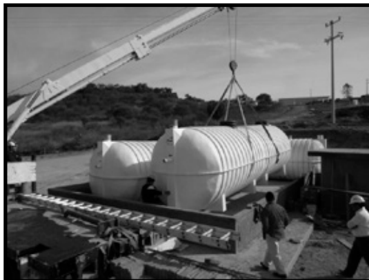
Imagen 74. Instalación de Planta de Tratamiento para Aguas Residuales generadas en campamentos y oficinas.
