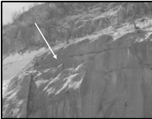
Ilustración 90. Verificación actividad de nidos por parte del personal de seguridad en ladera de margen izquierda.
