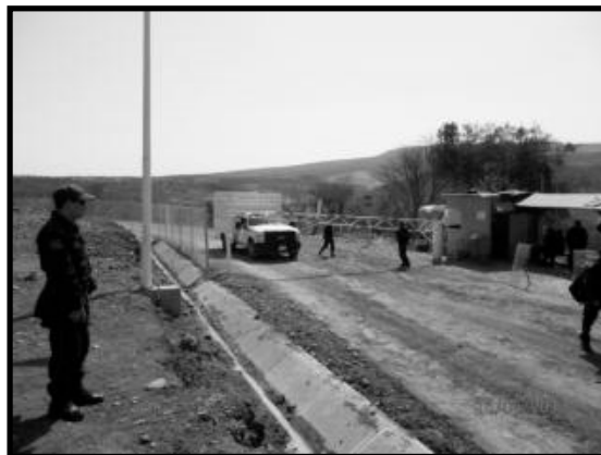
Imagen 55. Control en los diferentes accesos en la obra.
