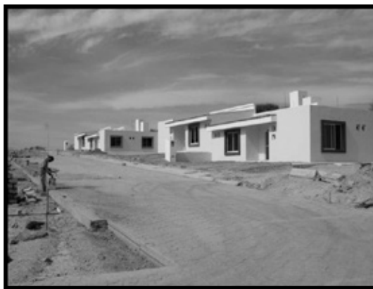
Imagen 45. Avances en la construcción.
