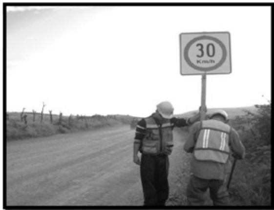
Imagen 30. Colocación de señalamientos viales.
