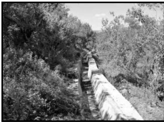
Imagen 76. Obras para el manejo control y alejamiento de aguas pluviales en las áreas de caminos internos de obra.
