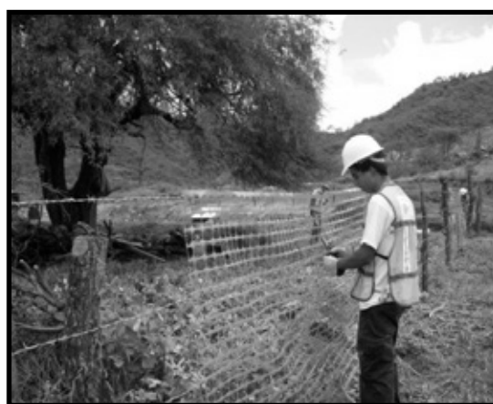
Imagen 65. Delimitación de la zona de construcción.
