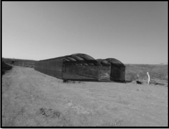
Imagen 60. Vista parcial de nave de malla sombra al 50%
