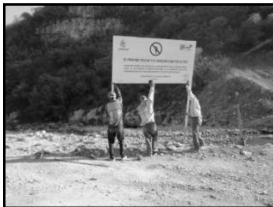
Ilustración 71. Carteles informativos/prohibitivos distribuidos en obra relativo a la protección de flora y fauna.
