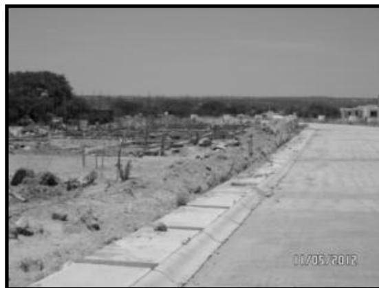
Ilustración 36. Instalación de infraestructura para las viviendas de la segunda etapa de construcción.
