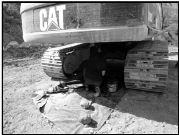
Imagen 57. Medidas de prevención de derrames de hidrocarburos en suelo.
