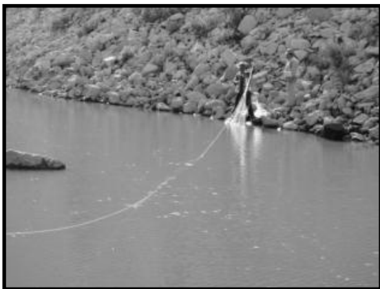
Imagen 94. Colocación de red para evitar el paso de fauna durante desazolve de aguas abajo
