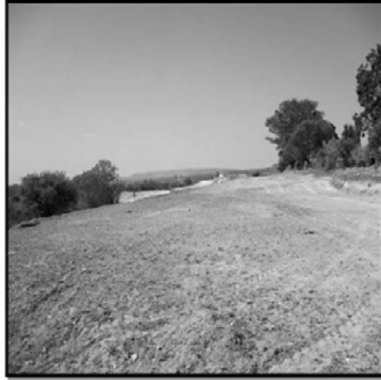
Imagen 30. Se observan las plataformas donde serán instalados los campamentos técnico-administrativos, así como los campamentos para el personal obrero.
