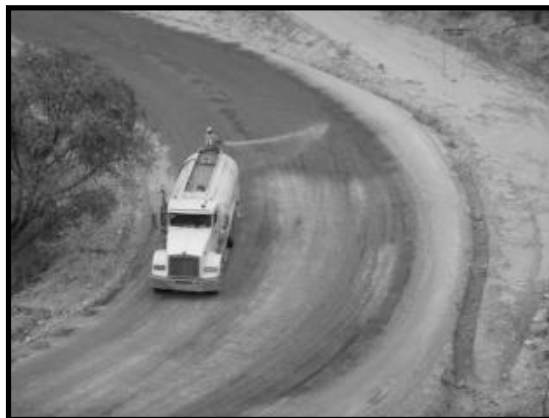
Imagen 26. Mitigación de polvos fugitivos mediante el riego de caminos.
