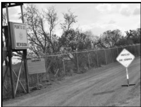
Ilustración 72. Puntos de control para acceso a zona de obra.
