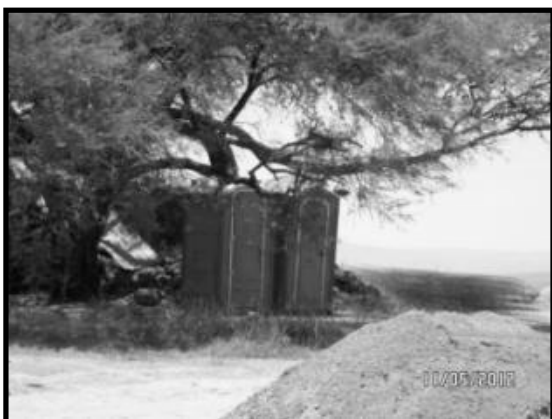
Ilustración 33. Instalación de sanitarios portátiles como parte del control de residuos.
