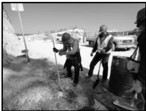
Imagen 87. Recuperación de suelo contaminado por derrames accidentales.
