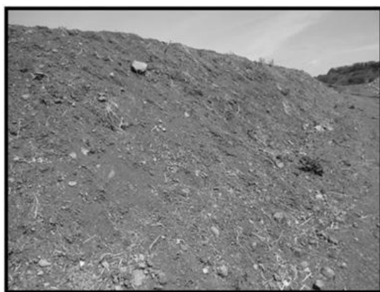
Imagen 26. Acumulación de material producto del despalme.
