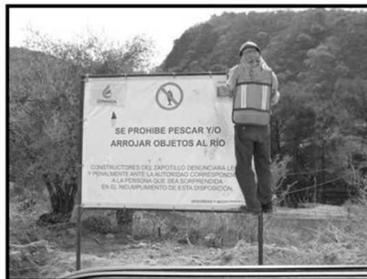
Imagen 15. Instalación de lonas prohibitivas/informativas a lo largo de la obra.
