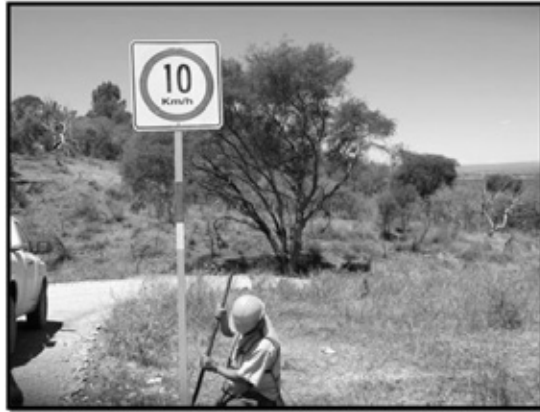
Imagen 33. Señalamientos de velocidad colocados en los caminos de acceso a la obra.
