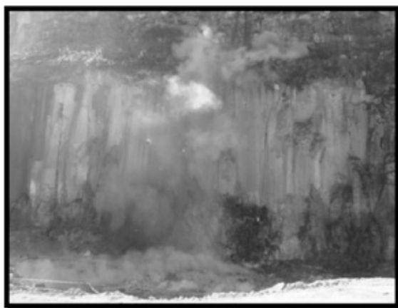
Imagen 16. Balconeo de materiales en zonas de alto riesgo, por desplome o colapso de materiales fracturados.
