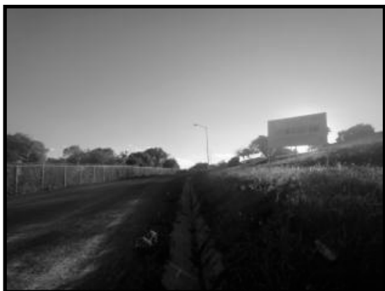
Imagen 56 Delimitación de la zona de construcción mediante malla ciclónica.
