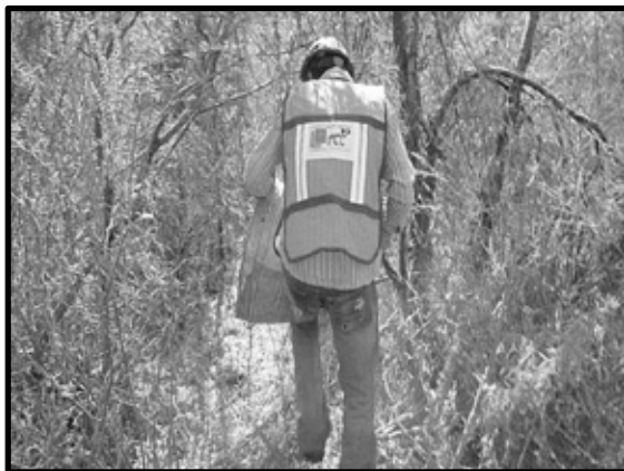
Imagen 78. Ahuyentamiento de fauna silvestre, previo a las actividades de construcción.
