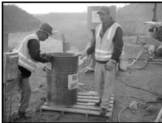
Imagen 18. Instalación de contenedores de 200L en los frentes de trabajo.
