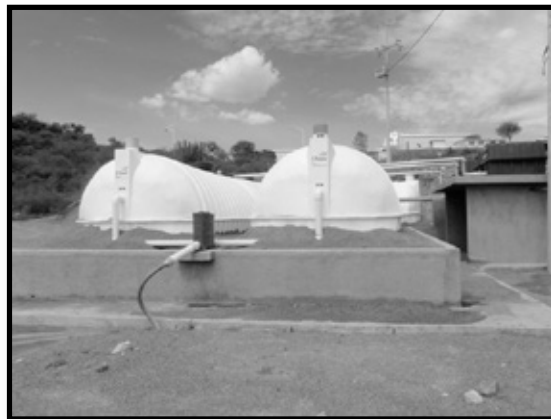
Imagen 24. Vista frontal de la PTAR.
