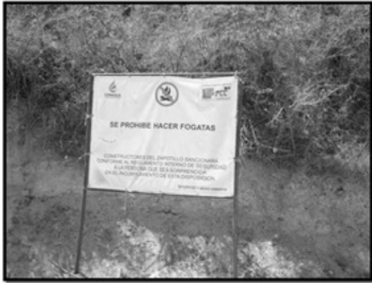
Imagen 18. Instalación de lonas prohibitivas de fuego en la zona de obra.
