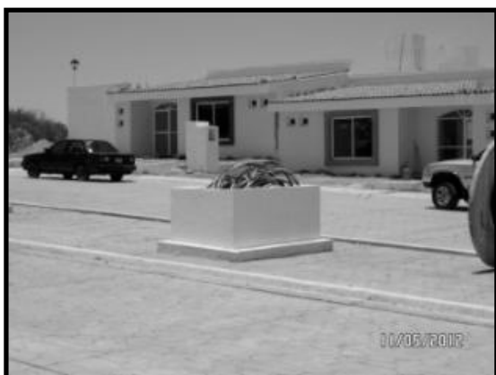
Ilustración 29. Vista de las viviendas que se construyen en la segunda etapa del proyecto.
