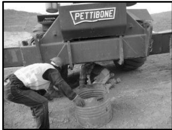
Imagen 82. Medidas preventivas para no ocasionar un derrame en el suelo durante las reparaciones fuera del taller de mantenimiento.
